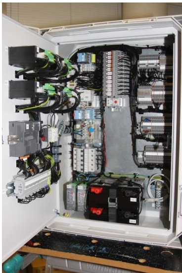
Aapeli 4+1 kokoonpanolla. Optioina 4 kpl vika-analysointoreita sekä paikallinäyttö.
